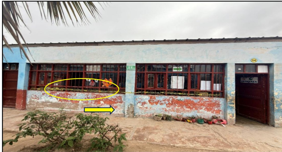
Imagen 6 Aula de 5 "C" de nivel primaria (alto riesgo) en clases
