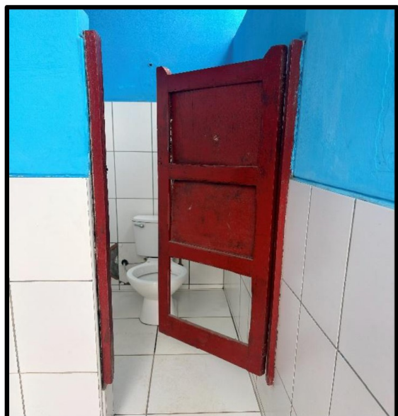
Imágenes 16 y 17 Servicios higiénicos de varones con cerámica rota y puerta incompleta
